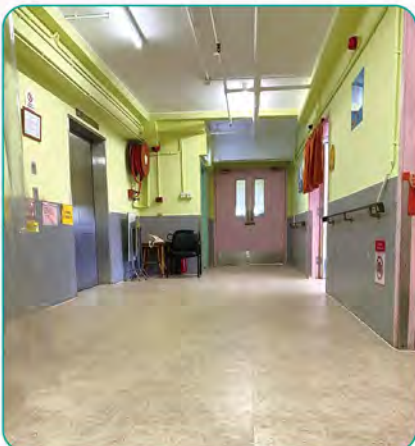
▲樓層翻新工程
